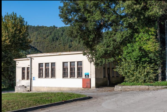
Cetrti obrok izvana
